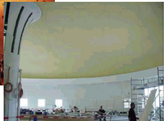
Eine Herausforderung an das CLIMATT-System: Die Kuppel des Casinos 2000 in Luxemburg mit einer GK-Decke und Akustikputzbeschichtung
