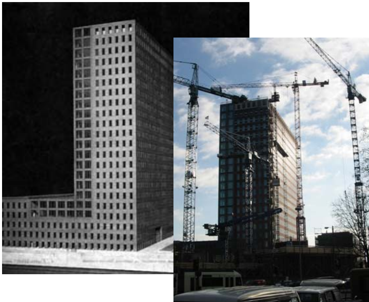
In dem neu erstellten Verwaltungsgebäude der IG Metall in Frankfurt am Main sorgt ebenfalls eine CLIMATT-Putzkühldecke auf 14.000 m 2 auch an sehr heißen Tagen für kühle Köpfe.
