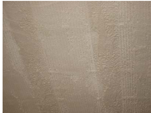
Putz vor dem Glätten Hier lässt sich die exakte Positionierung der Röhrrchen innerhalb der Putzschicht erkennen.
