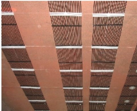
Gewerkunabhängige Befestigung des CLIMATT-Systems an der Rohbetondecke
