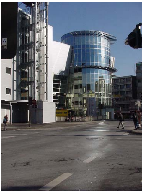
Die CLIMATT- Kühldecke Typ MAK-RE in der Technikerkrankenkasse Siegen
